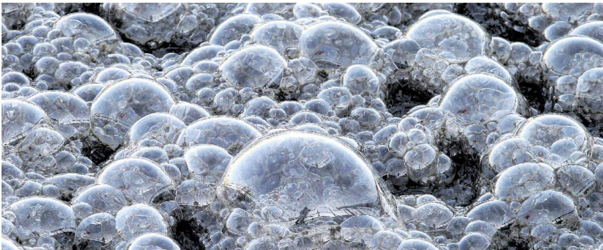
Blick ins belüftete Belebungsbecken des Klärwerks Wassmannsdorf bei Berlin. Erste Kommunen beginnen, die anfallenden Faulgase gewinnbringend in Strom zu verwandeln.
