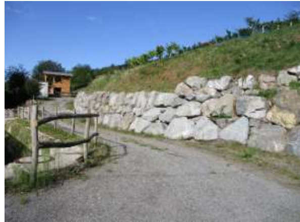
Hangsicherung durch Steine (Fläche Ludinmühle).
