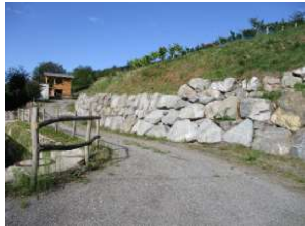
Abb. 3: Hangsicherung durch Steine.
